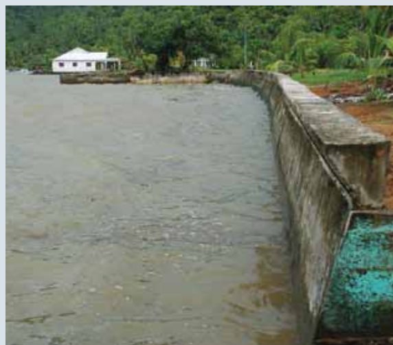
Mur de protection contre l'érosion (Baie de Gahi)
