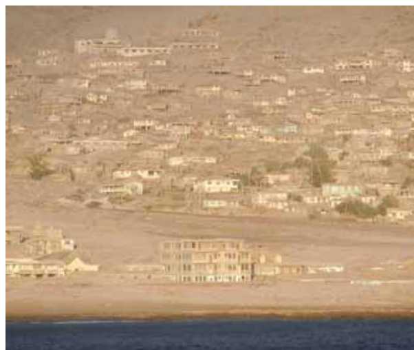
La ville de Plymouth, ancienne capitale de Montserrat, a été complètement ensevelie par une éruption volcanique en 1997
