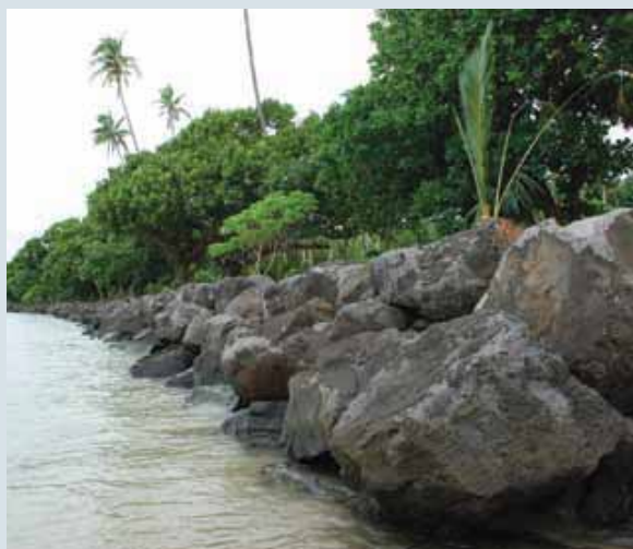
Enrochement en bord de mer (Vaitapu)
