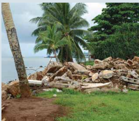
«Enrochement» sauvage à l'aide de débris de constructions (Liku)
